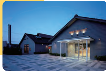
「まちなかキネマ」…計437名収容の大小4つのスクリーンがあり、無料駐車場完備。
